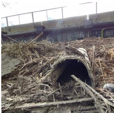
Tuyau trop-plein envasé avant travaux
